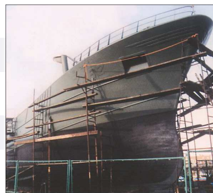
Hiekkapuhallus SA 2.5 ZINGA 1 x 80 \mu Eristys MIO 1 x 60 \mu Pinta Pu 1 x 60 \mu
